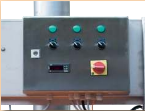
Panel obsługi ze zintegrowaną szafką rozdzielczą
